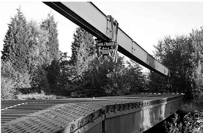
Il sistema "ponte di supporto 45 m"
