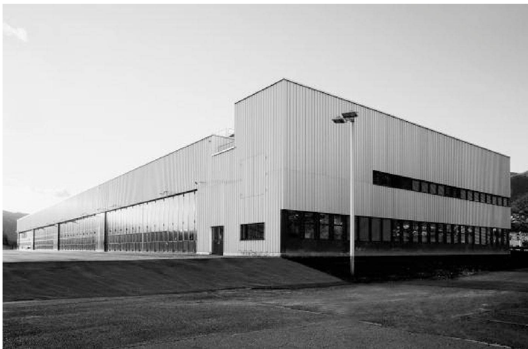
Veduta dello stabile RILOC
