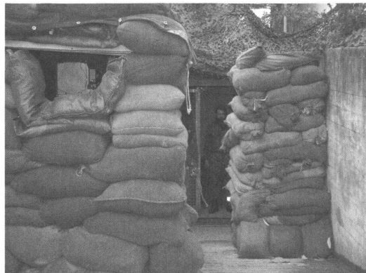
Accesso della centrale d'impiego.
