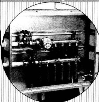
*il sistema di installazione per acqua potabile fredda e calda, resistente alla corrosione*
