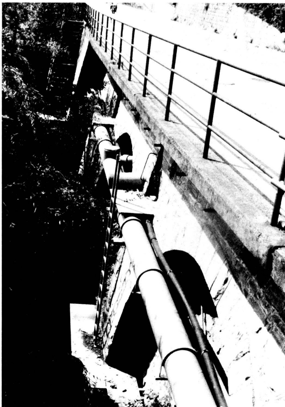
Camere di mina del 1939: foto in direzione della frontiera. Opera minata (ora abbandonata). In primo piano è indicato l'accesso alle camere di mina (al disotto è visibile il collettore depurazione CDL costruito circa 40 anni dopo) (Foto A. Rima, 1989).
