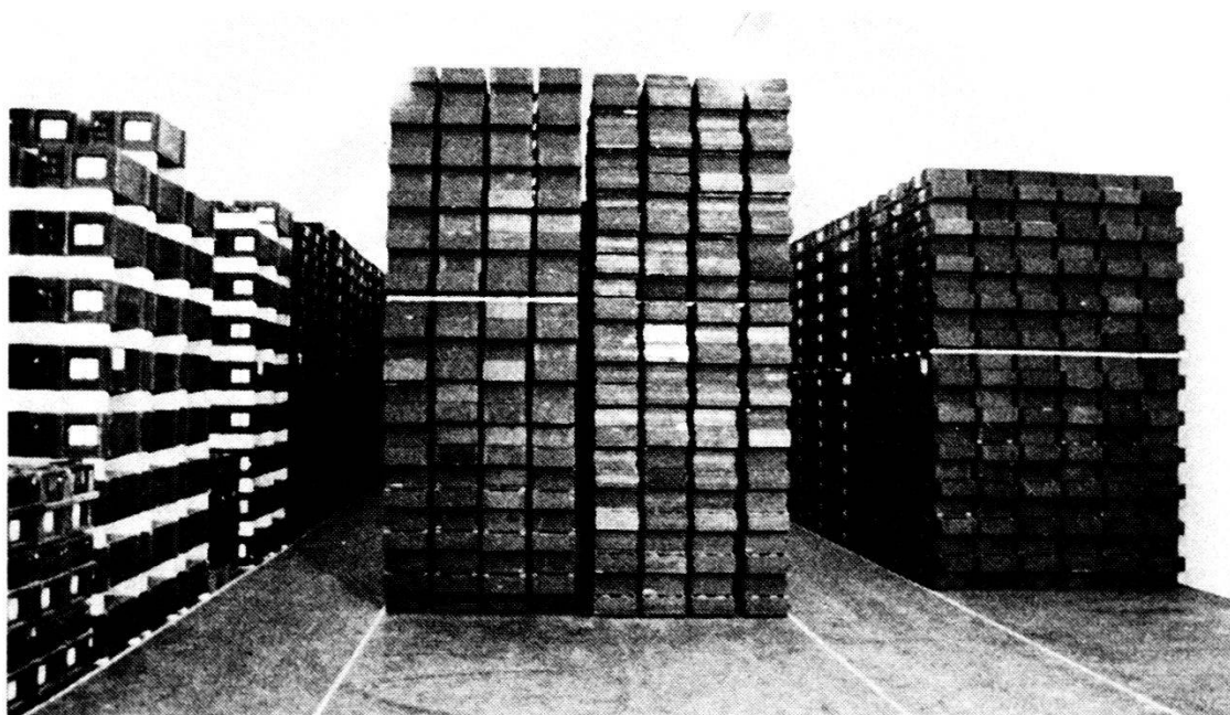
Deposito sotterraneo di munizioni.
