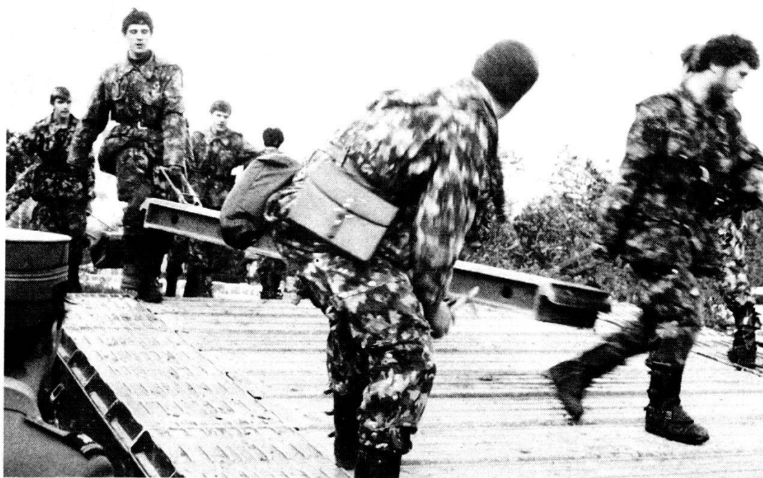
Fase di costruzione del ponte fisso 69, da parte dei militari ticinesi.
