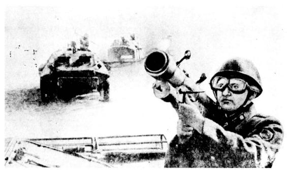
Fig. 22. SA-7 Grail il cosiddetto lanciarazzi contraereo «Fliegerfaust» dell'esercito sovietico. Raggiunge l'obiettivo fino a 3000 m di altezza e fino a 4000 m di distanza.
