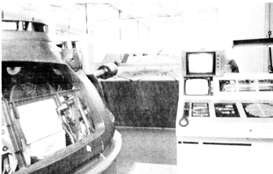
Simulatore elettronico di tiro «ELSAP» per l'istruzione dei soldati carristi.
