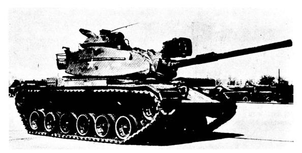
**M 60** — *dati tecnici:* peso per il cbt: 50 t - Armamento: 1 can 105 mm (54 colpi); 1 mitr in torretta: 7,62 mm; 2 mitr DCA: 7,62 mm - Motore/potenza: Diesel 750 PS; rapp potenza/peso: 15,8 PS/t; velocità max: 48 km/h; autonomia: 480 km - Equipaggio: 4 uomini.
