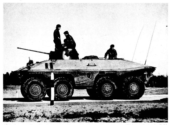
Dati tecnici: peso: 19 t (pronto al cbt) - Armamento: 1 can 20 mm (200 colpi); 1 mitr 7,62 mm - Motore/potenza: Diesel 390 PS (pluricarb); rapp potenza/peso: 20,5 PS/t; velocità max: 90 km/h su strada, 10 km/h in acqua; autonomia: circa 800 km; trazione su tutte le ruote con guida su 2 o 4 assi - Equipaggio: 4 uomini.
