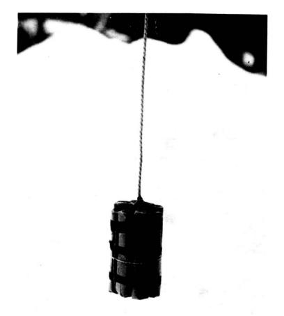
3. completata la carica si procede a disporla in senso perpendicolare al piano di scorrimento della massa di neve, dando quindi seguito all'esplosione.
