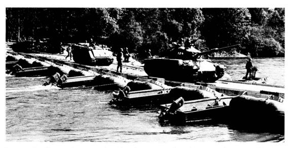
Passaggio di mezzi meccanizzati sul ponte galleggiante 61. Durante l'impiego dello stesso ogni settore è tecnicamente sorvegliato da un milite; alle sue spalle è l'ufficiale responsabile. Il cdt del ponte è l'unico autorizzato e responsabile per qualunque truppa transitante dal settore di preparazione del passaggio al settore di disimpegno comprendente quello di transito, situati su un asse di ca. 1 km (dipendentemente dal settore topografico).
