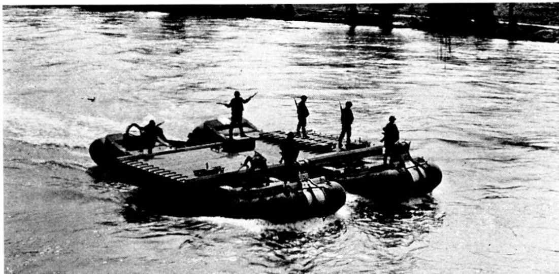
Trasporto a monte di una sezione del ponte centrale. Tatticamente il ponte (o meglio i suoi elementi) viene montato indipendentemente, al coperto, con camuffamento naturale vegetale, a valle del punto X. A un comando del cdt del ponte questi elementi raggiungono il punto di costruzione.
