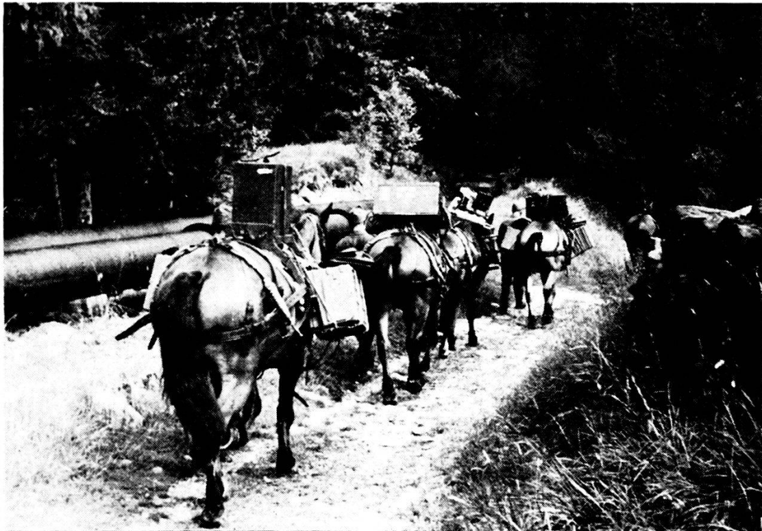
Stazione SE-222 someggiata
