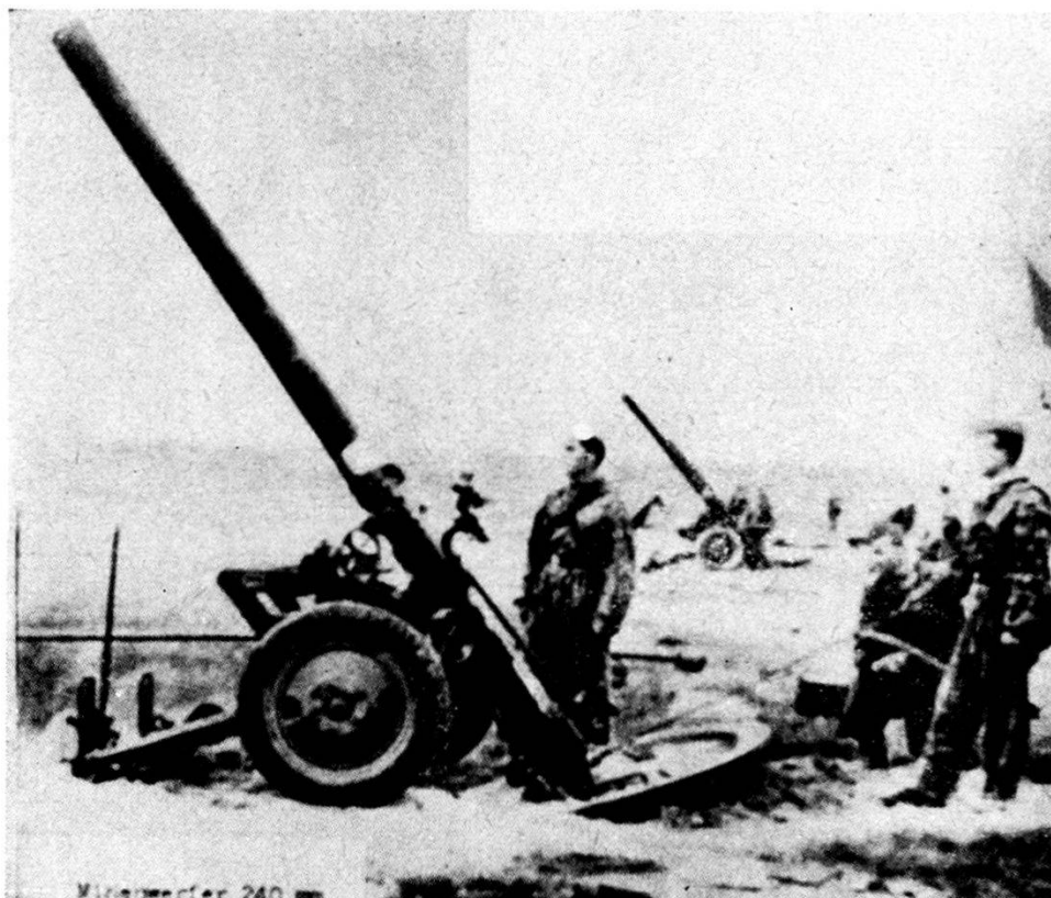
5. URRS: Lancia-mine pesante, calibro 24 cm., peso dell'arma 2,5 t., portata 10 km.
