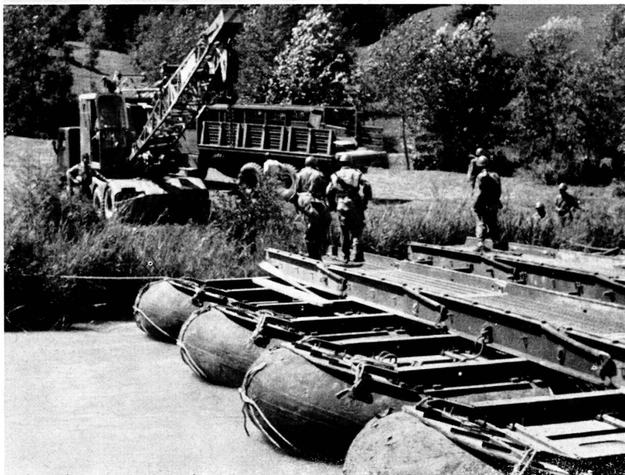
ITALIA: truppe della Divisione cor. Ariete: In alto: Sostegni pneumatici per ponti pesanti. In basso: Ponte pesante su pneumatici.
