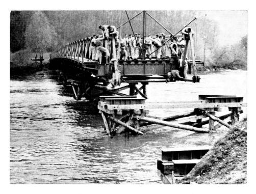
Ponte d'acciaio a traliccio 52 sulla Reuss.
