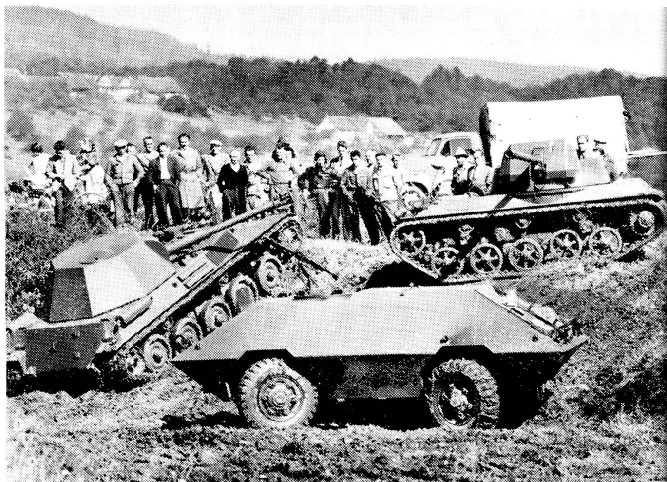
Dimostrazioni di veicoli anticarro a Weinfelden : a sinistra : il « Pirata » (Belgio) armato di un cannone anticarro di 9 cm.; in primo piano un blindato (Germania, truppe di front.) con doppia direzione; l'adattamento svizzero dello « Scorpione », con cannone 9 cm.
