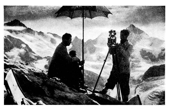
Fig. 1 — Fotogrammetria terrestre: rilievo con il fototeodolite
