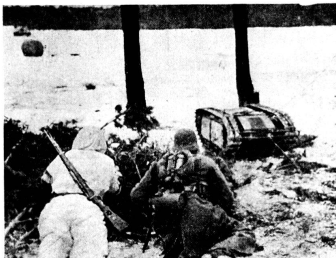
16. « Goliath », la mina diretta con onde radio-elettriche, porta l'esplosivo fino alla copertura da distruggere.
