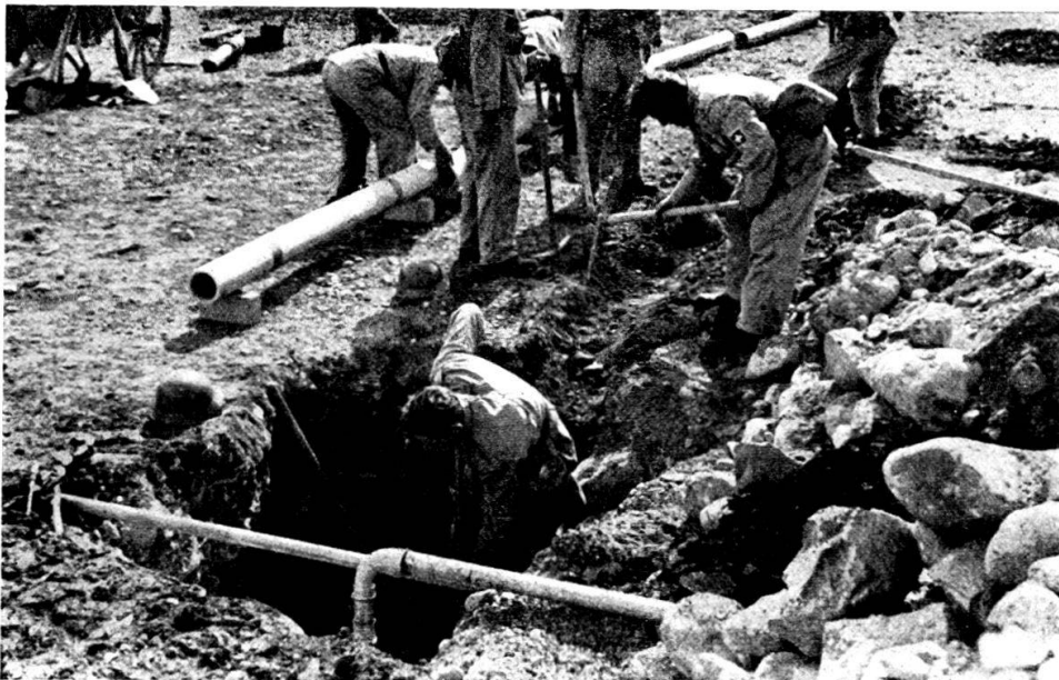
Servizio tecnico: riparazione di condotte distrutte.
