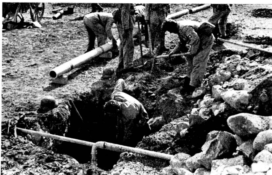
Servizio tecnico: riparazione di condotte distrutte.
