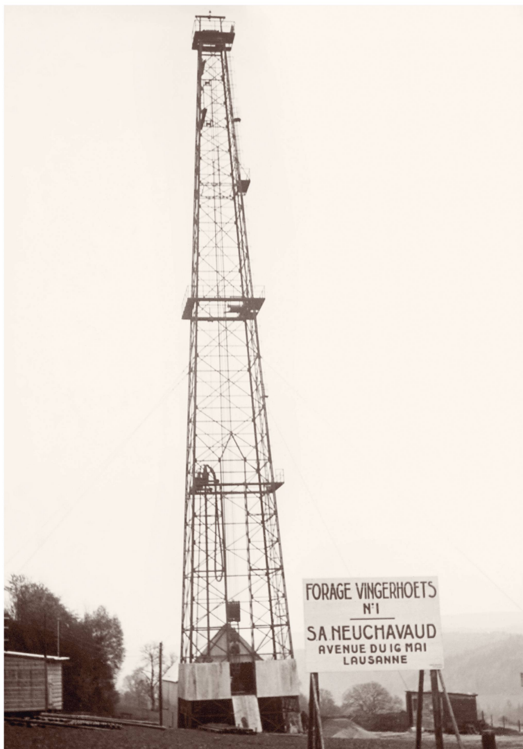
Tour de forage de Cuarny-1. Le sondage est lancé par la société Neuchavaud en 1936. La profondeur atteindra 2288 mètres sans pour autant en extraire du pétrole. Vers 1936-1939.
