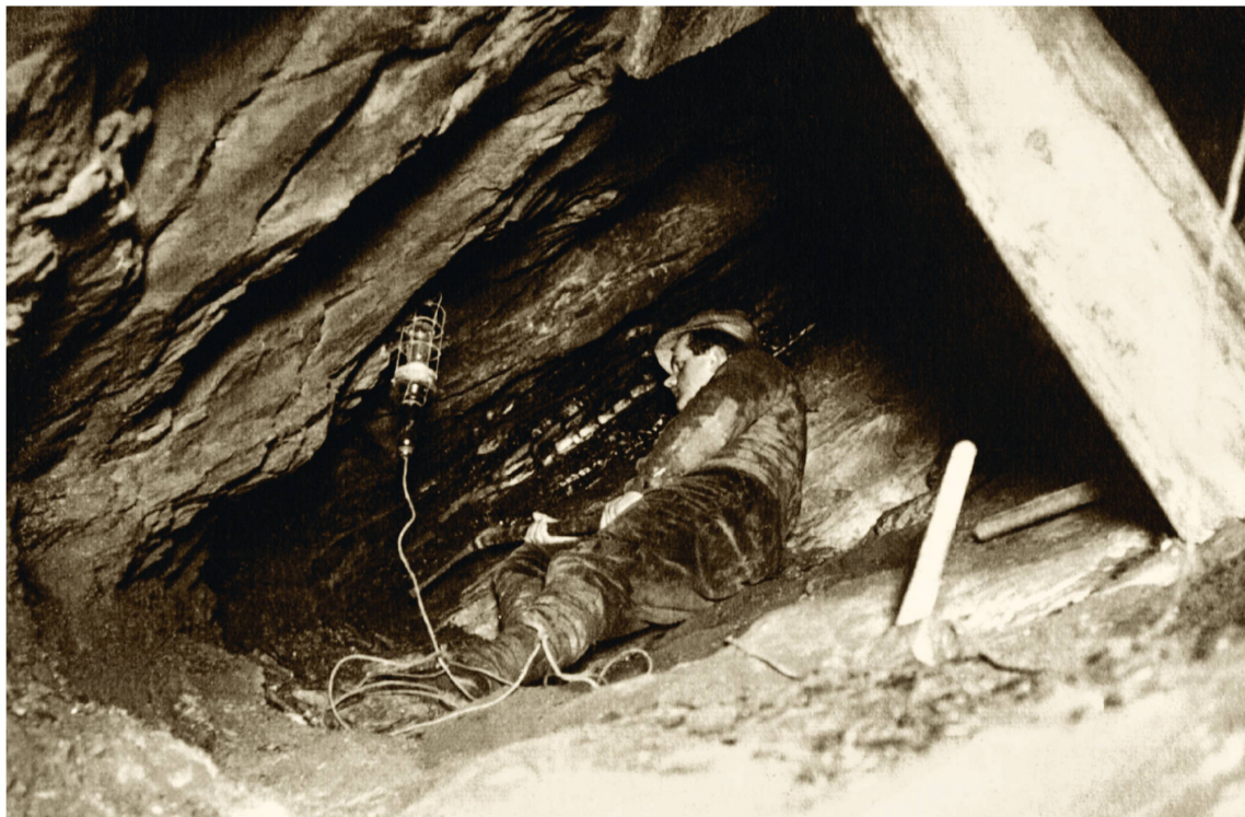
Exploitation du gisement et l'extrémité d'une galerie non encore étayée, mine dans la région d'Oron-La-Ville, vers 1918-1919.
