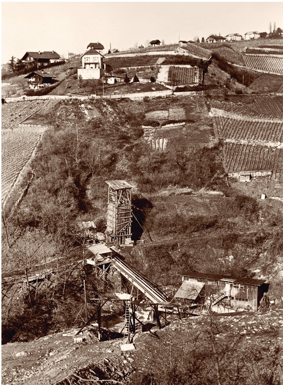
La mine de la Paudèze-Flonzel en 1945. L'entrée se trouve sur la rive gauche, à côté du hangar. Une passerelle franchit le ravin du Flonzel et permet d'alimenter le silo en bois situé sur la rive droite où des camions viennent charger le charbon. Voir page suivante.
