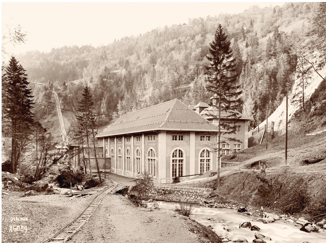
Le bâtiment abritant la salle des machines de l'usine de la Peuffeyre, reliée à la halte ferroviaire de Fontannaz-Seulaz par un funiculaire industriel visible en arrière-plan.
