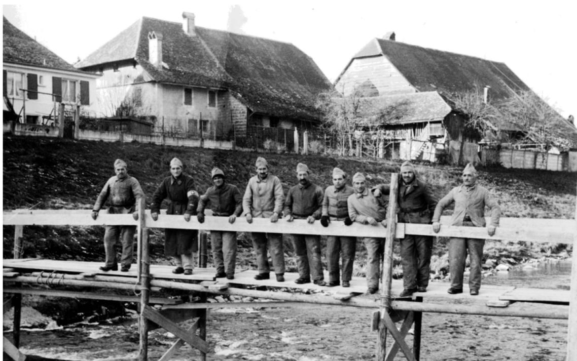
Fig. 6. Passerelle construite sur la Broye par le Service technique payernois. 1943. Photo Juriens.
