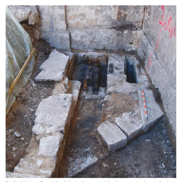
Fig. 38. Vallorbe - Place du Pont 3. Vue des fosses qui abritaient les roues hydrauliques de l'ancienne scierie (photo C. Wagner, AC).
