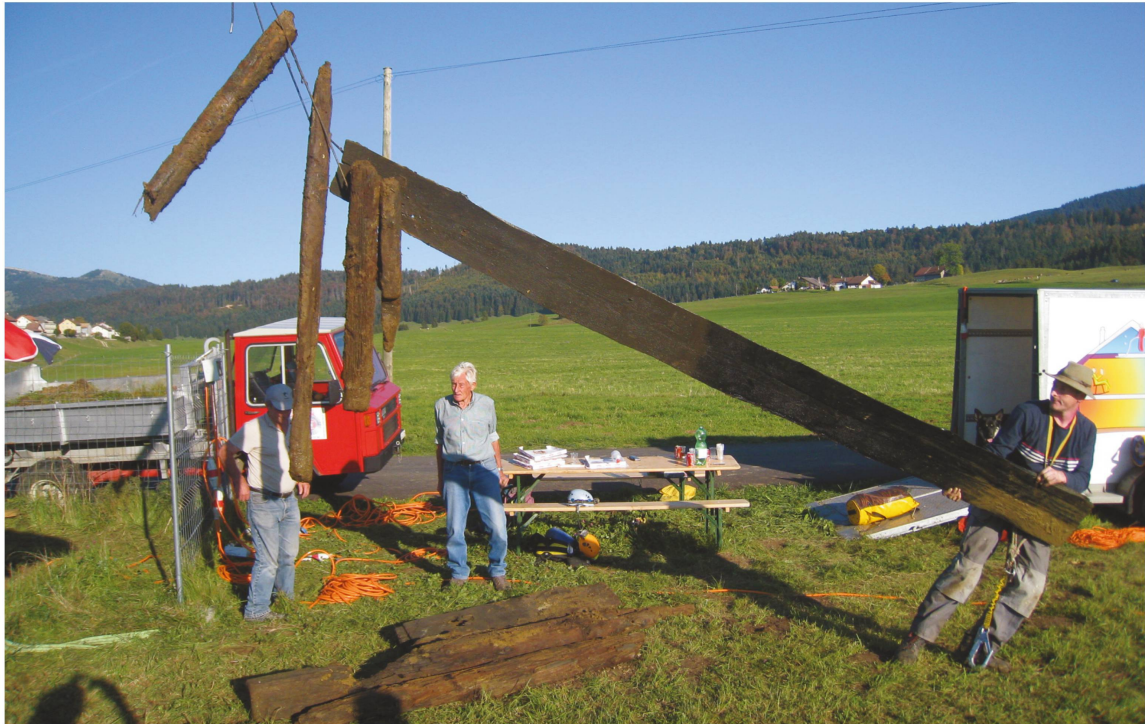
Fig. 32. Sainte-Croix – L'Auberson. Extraction des bois (photo M. Liboutet, AC).
