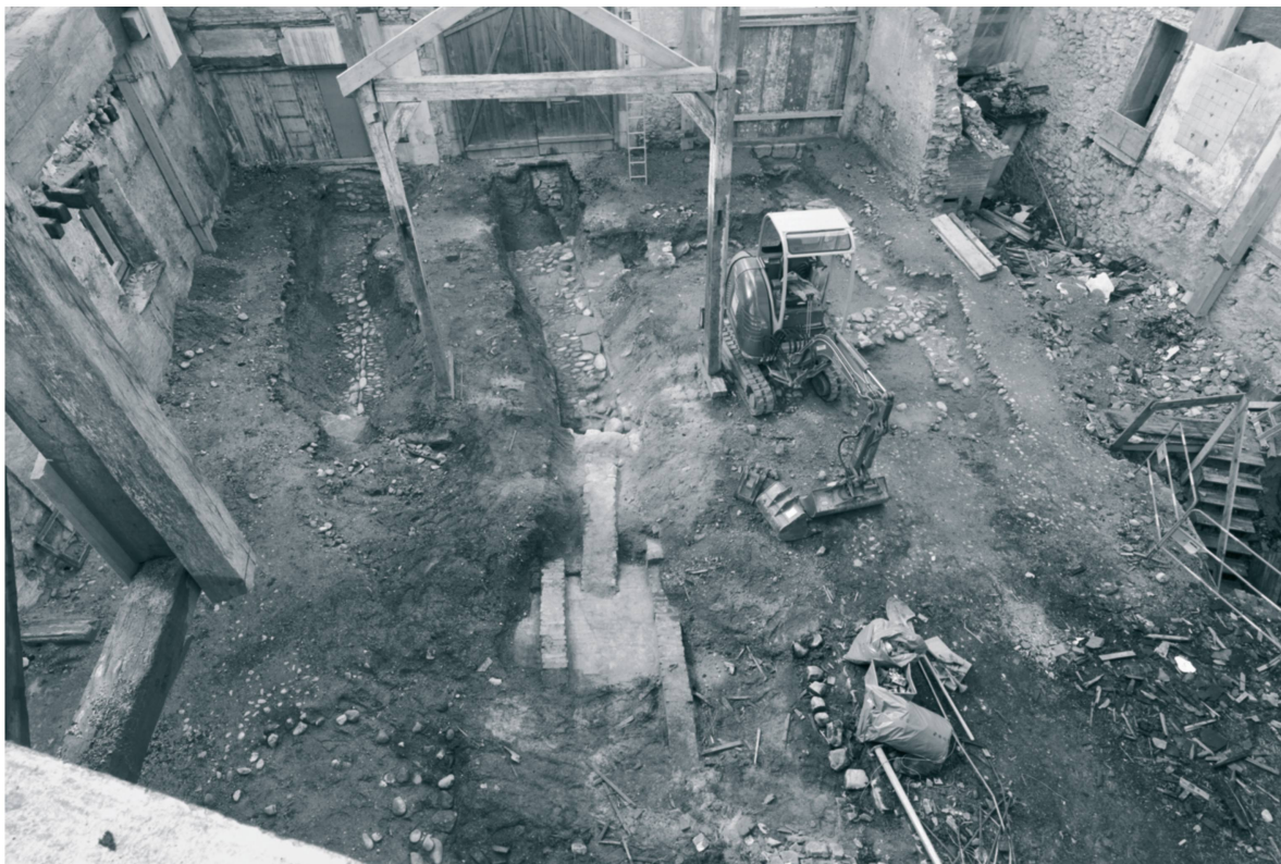
Fig. 1. Aubonne – Rural de l’Hôtel de la Couronne. Vue générale. Le pavage en galets est visible dans les deux tranchées (photo Fibbi-Aeppli, Grandson).
