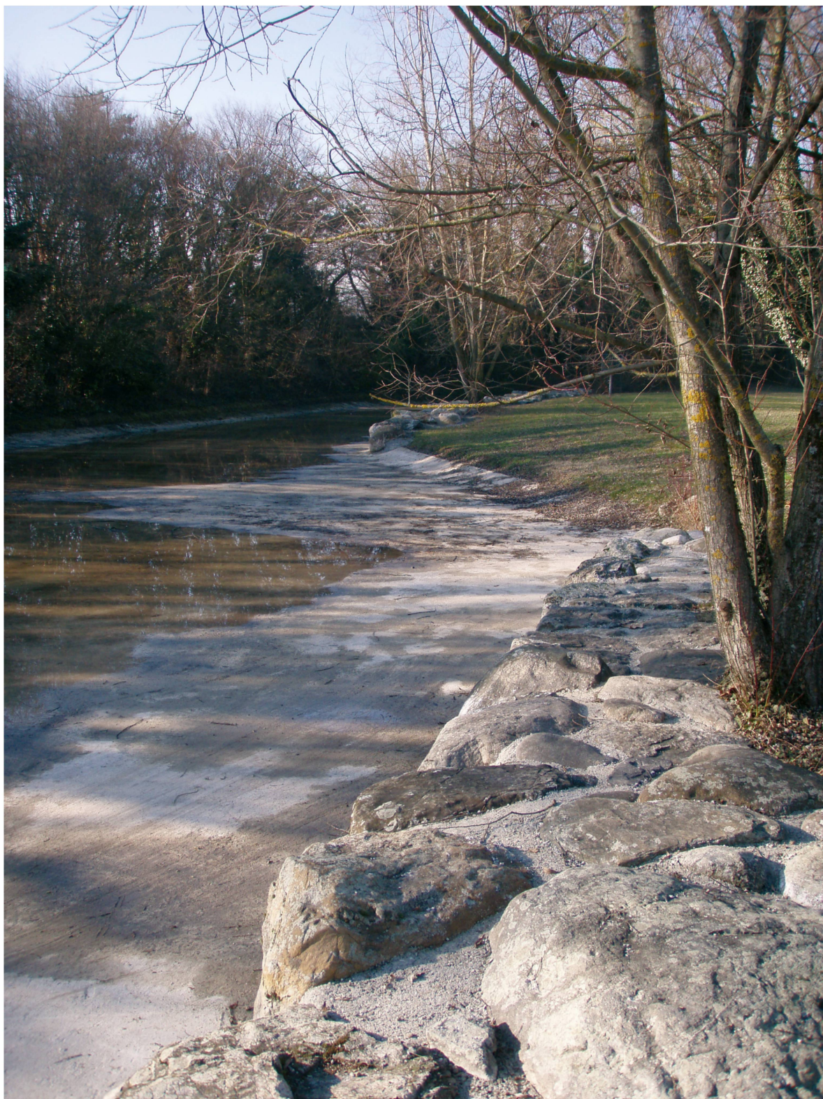
Fig. 12. Lausanne – Vidy. Promenade archéologique. Vue d'ensemble en direction du sud-ouest de la digue romaine reconstituée, après bétonnage des interstices entre les blocs (photo C. May Castella, AC).
