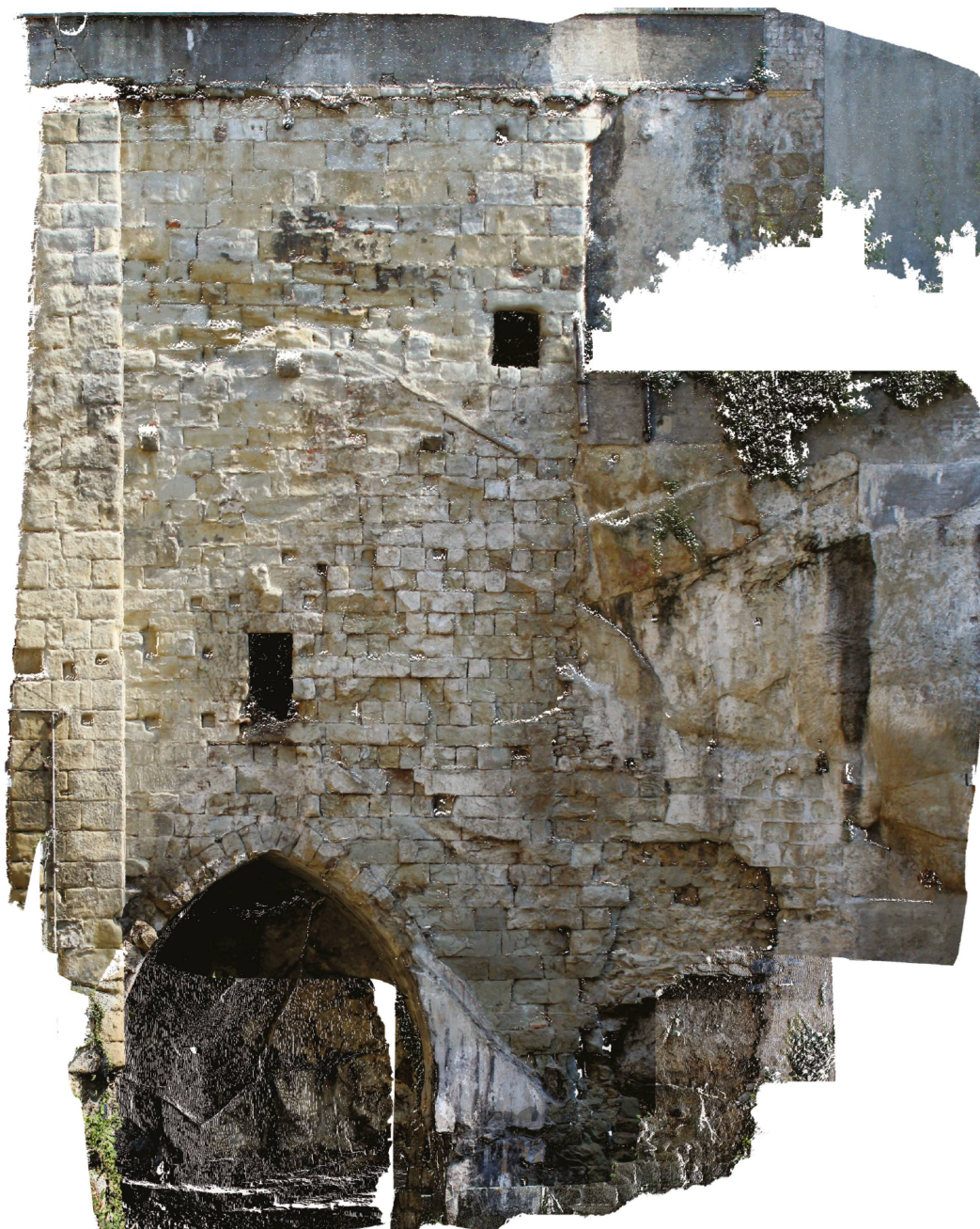
14 Lausanne – Mur de terrasse du gymnase de la Mercerie. Vue du mur après l'élimination de la végétation et avant les travaux de restauration et de consolidation (photo bureau BBHN SA, Épalinges).
