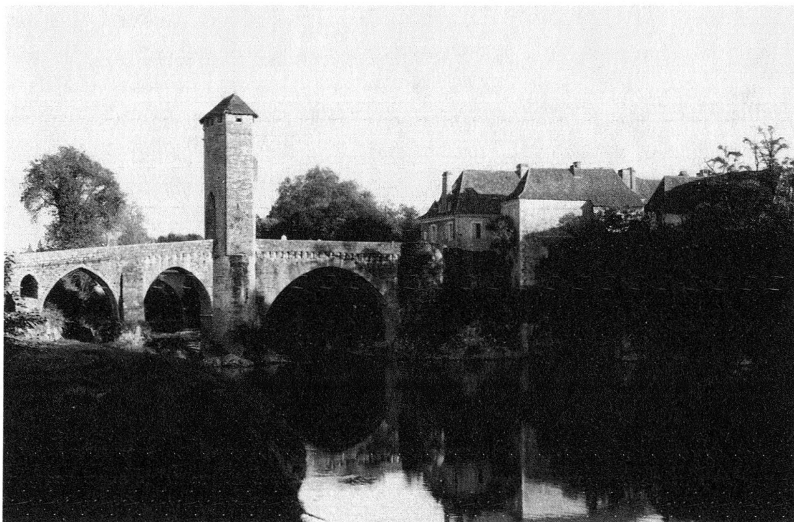
8 Orthez, pont sur le Gave, sans doute du xiv e siècle, avec son tablier large de 3,10 m et sa tour de 4,20 sur 8 m (photo Jean Mesqui).
