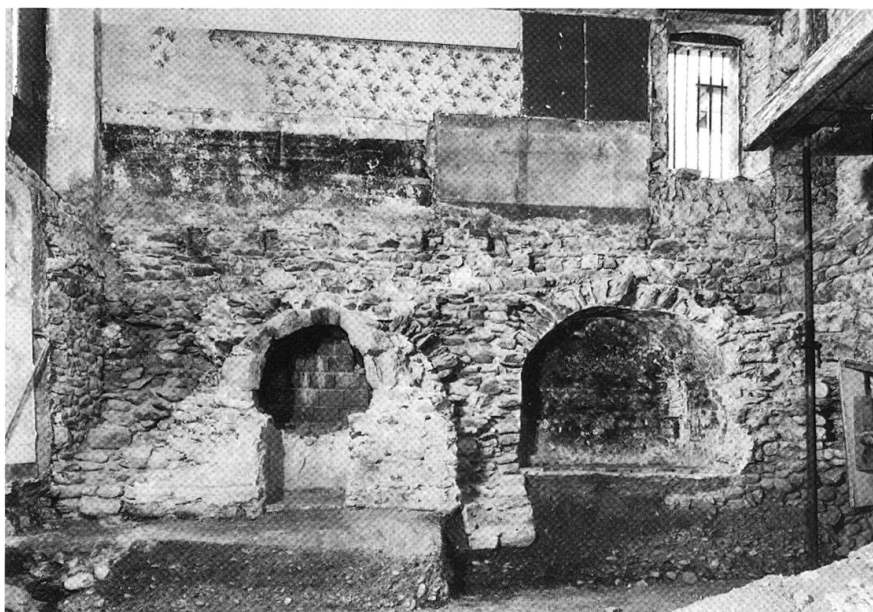
12 Vevey – Rue des Deux-Marchés n° 34. Local nord-ouest, rez-de-chaussée, vue vers le nord. Vestiges du pont et du four aménagé ultérieurement sous une des arches de celui-ci. (Photo Fibbi-Aeppli, Grandson)
