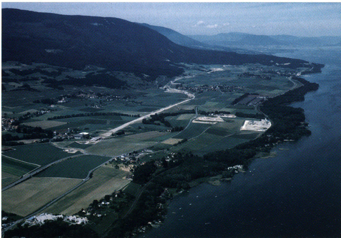
FIGURE 9 Onnens – Concise. Vue aérienne en direction du nord-est de l'autoroute A5 en construction, en été 2001. (Photo C. Falquet – AC)
