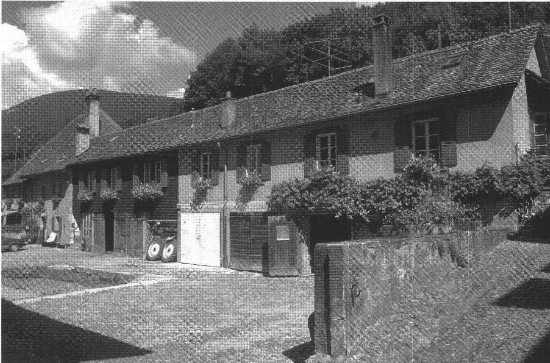
Fig. 34. L'ancien bûcher de 1800 et le logis du vigneron, construit entre 1806 et 1822, état en 1997.
