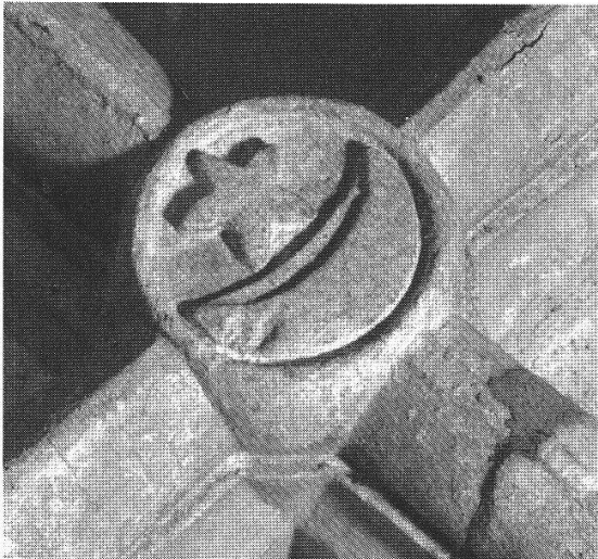
Fig. 24. Petit cloître de La Lance, clef de voûte, motif héraldique ? État en 1987.
