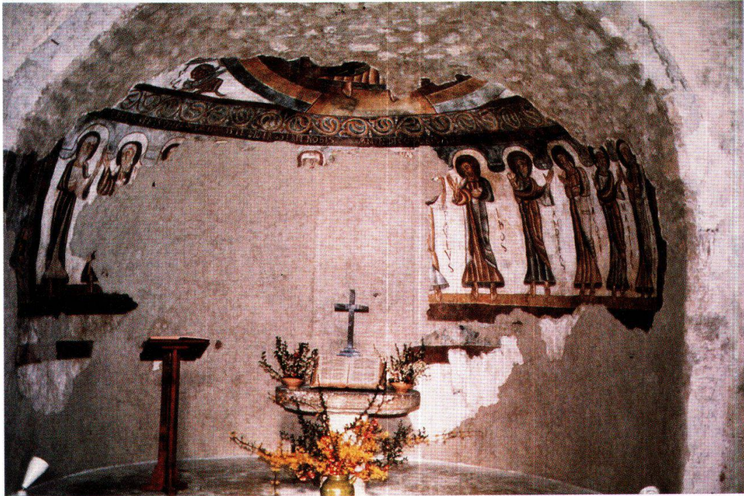
Planche C – Après la restauration Théo Hermanes (1972 à 1992)
