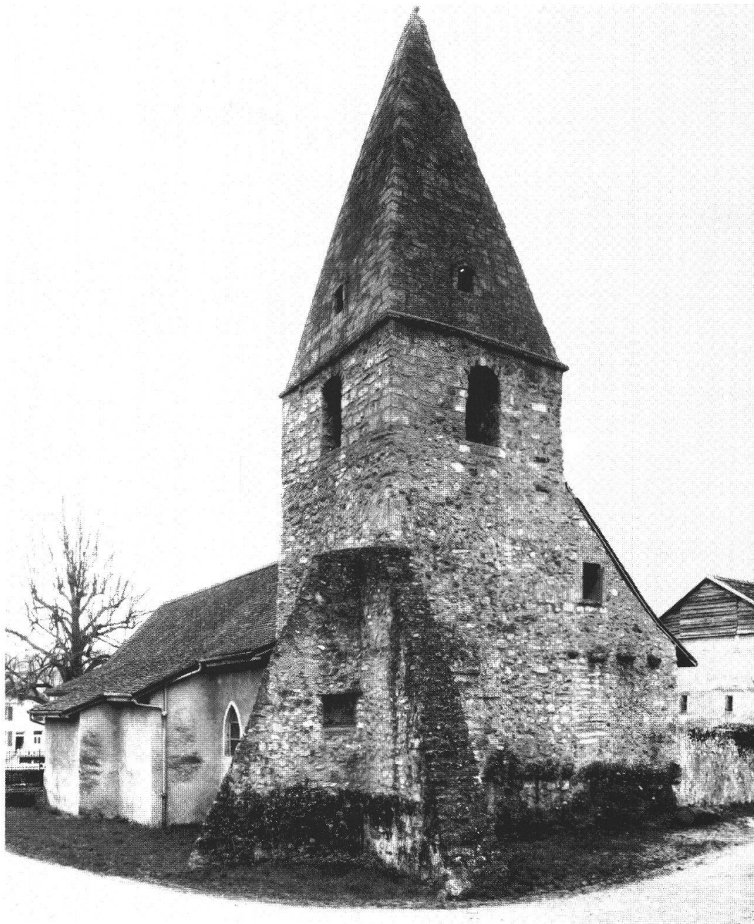
1. Vue de l'église depuis le nord-ouest.
