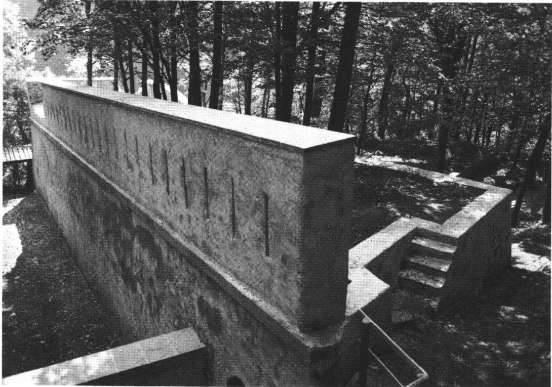
Fig. 5. Bex – anciennes fortifications Dufour – la batterie de l'Arzillier (1831-1848), après les travaux de restauration.
