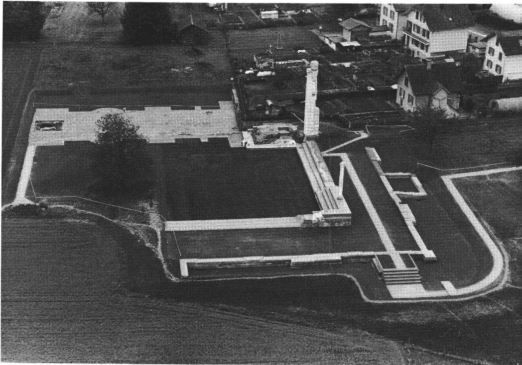
Fig. 3. Avenches – Sanctuaire du Cigognier. Vue aérienne de l'aménagement achevé en 1987 Photo: R. Glauser (MRA).
