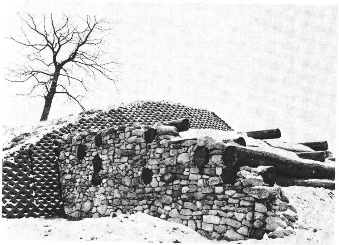
Fig. 10 et 11: Gressy – Rempart de la fortification helvète de Sermuz. Reconstitution d'une partie de la structure en 1987. Photo: M. Klausener MHAVD.
