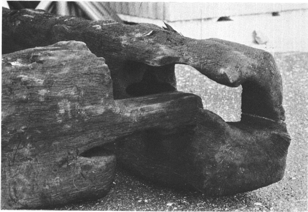
Fig. 13. Lausanne-Vidy. Secteur I. Cadre de bois soutenant l'un des puits. (Photo IAHA)
