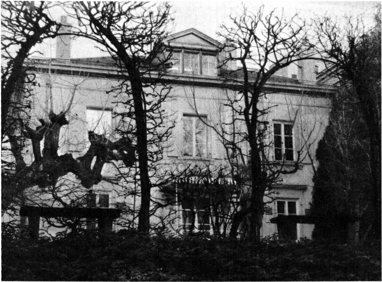
Fig. 9 — Le Presbytère, façade sud. (Photo M.J.)
