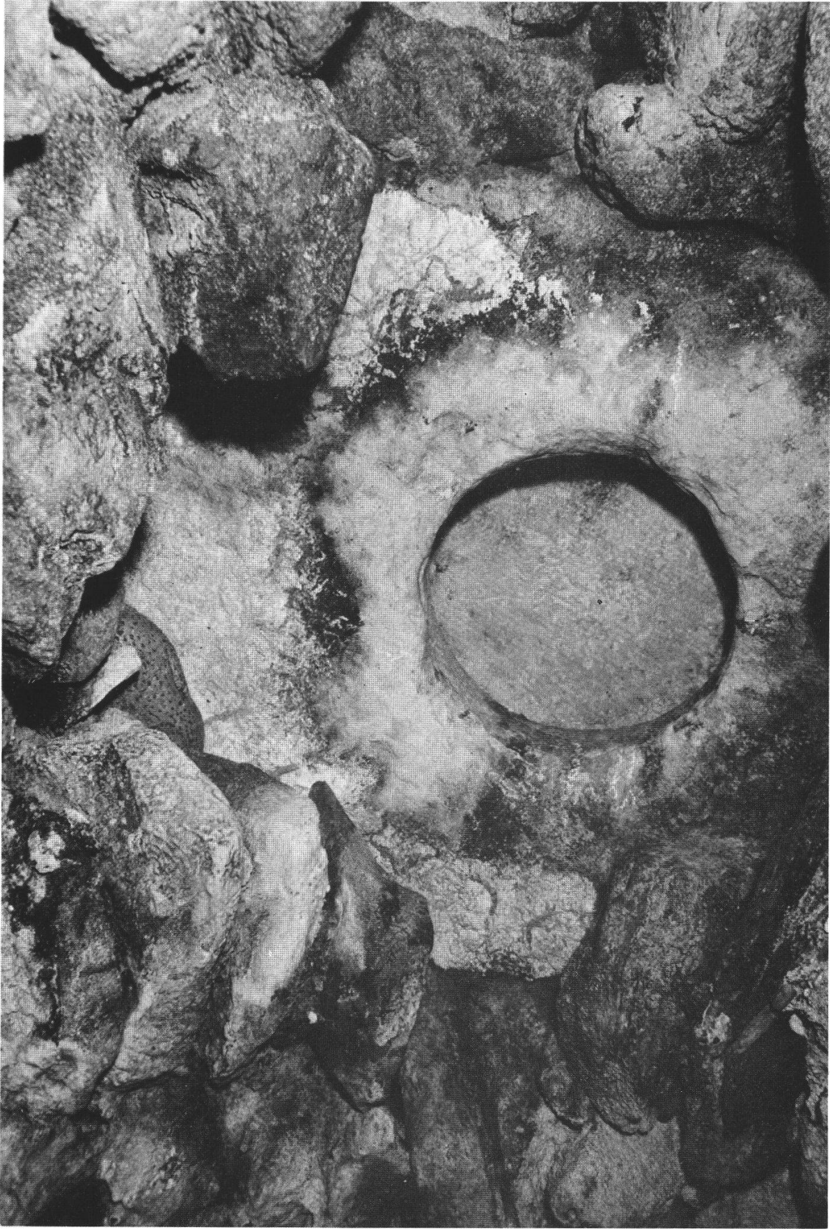
Fig. 3 – Trou d'homme dans la voûte du cloaque (Photo Ed. Berger, Nyon)
