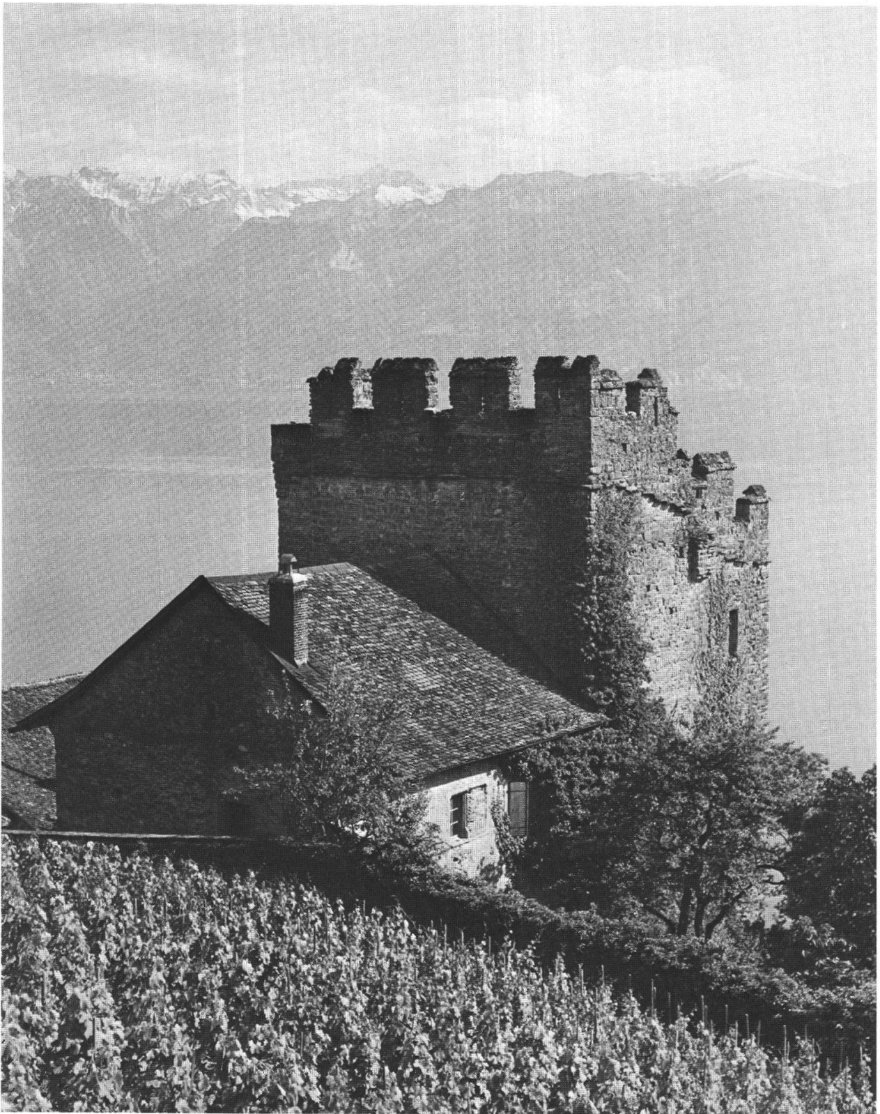
La tour de Marsens vue du nord, 1946 (Photo Belalp, Burgat et Paris, Lausanne)
