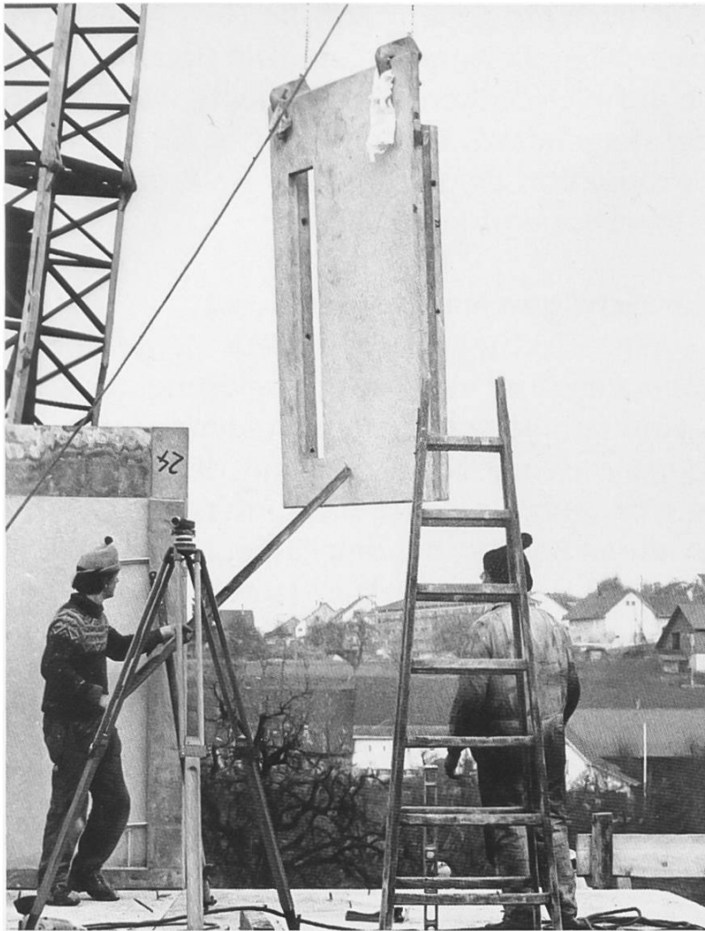
Baustelle mit dem selbst entwickelten Elementenbausystem «Mergenthaler»
