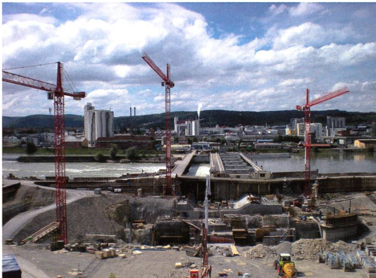
Baustelle Maschinenhaus des neuen Wasserkraftwerks Rheinfelden, 02.08.2008. (Bild U. Urwyler)
