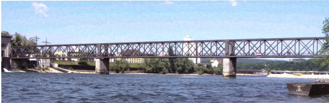
Der alte Eisensteg
