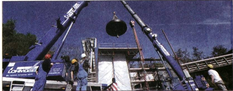
Am Platz des neuen Info-Pavillons wurde der Rotor in den Stator des Generators eingehoben Foto: Energiedienst
