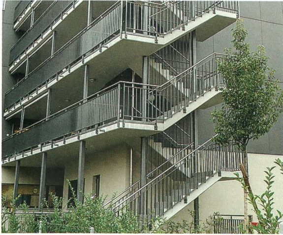
Geländer Altersheim Möhlin
