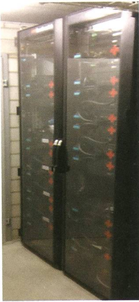
Batterieschränke des elektrischen Speichers im Mehrfamilienhaus der Wohnbaugenossenschaft Zähringer
