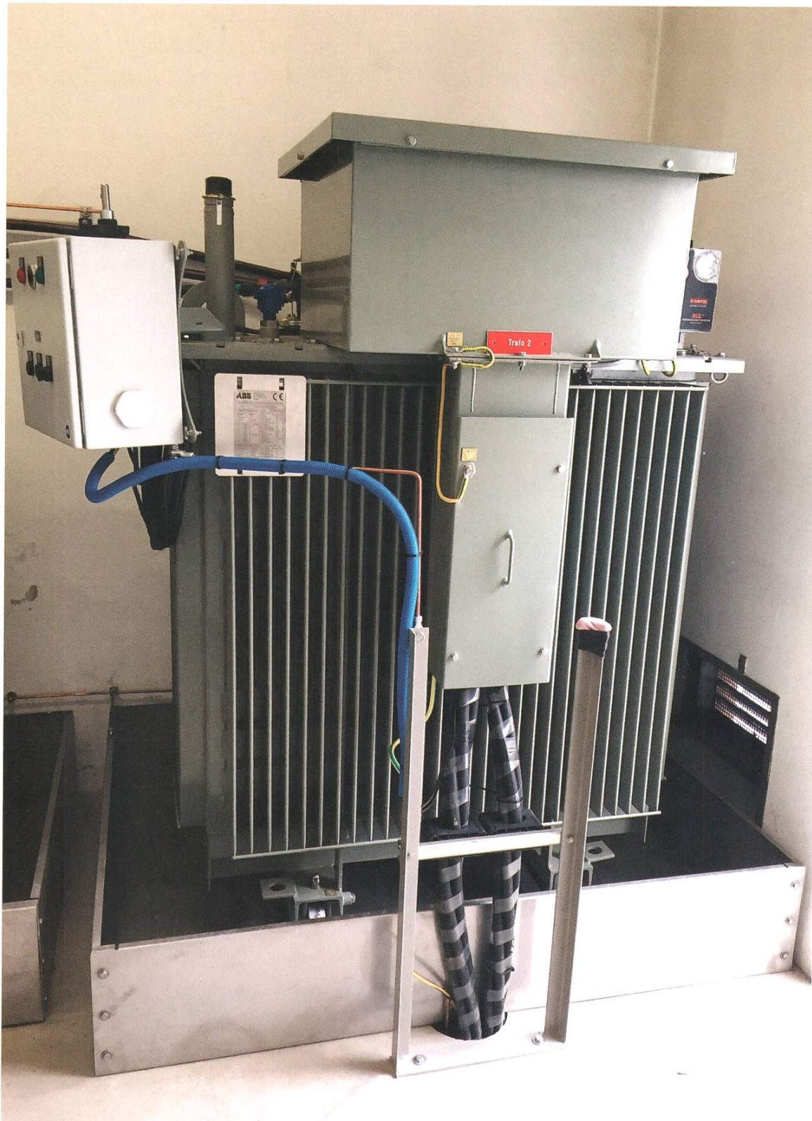
Regulierender Trafo in der TS Kreuzmatt (links: beiger Steuerkasten für die Regulierung, das Zusatzgerät für die Regulierung ist im Trafo integriert; oben: graue Abdeckung zur Reduktion der elektromagnetischen Felder)
