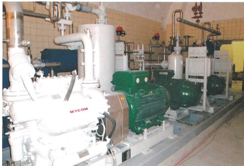
Die Wärmepumpen: 2 x 1 Megawatt
