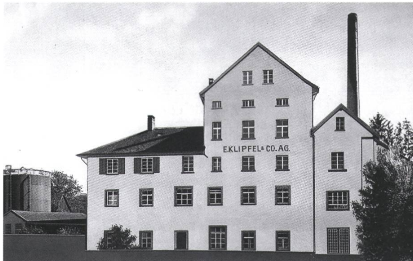
Fabrikansicht um 1970 / Links sieht man einen Melasse-Tank
