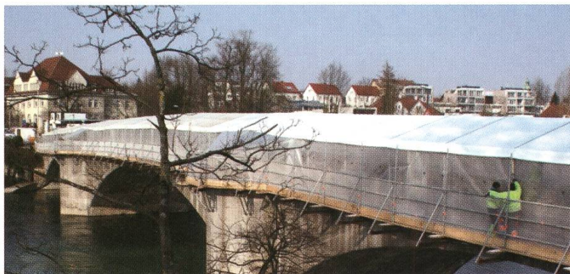
Sanierung der alten Rheinbrücke.
