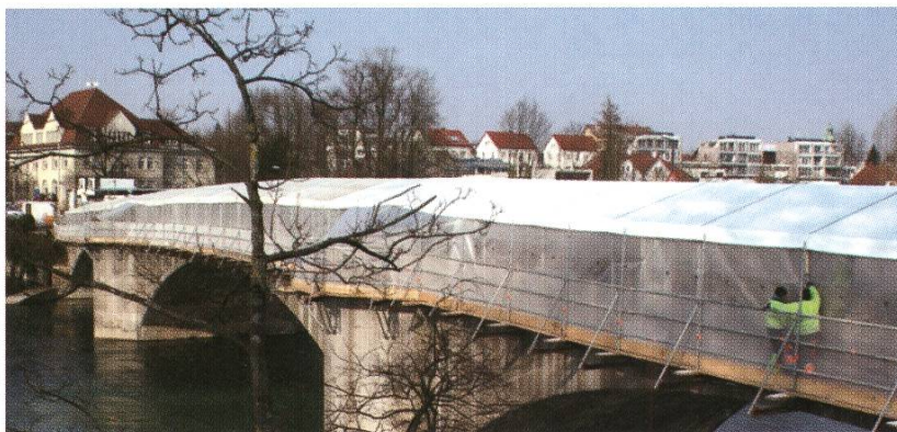
Sanierung der alten Rheinbrücke.
