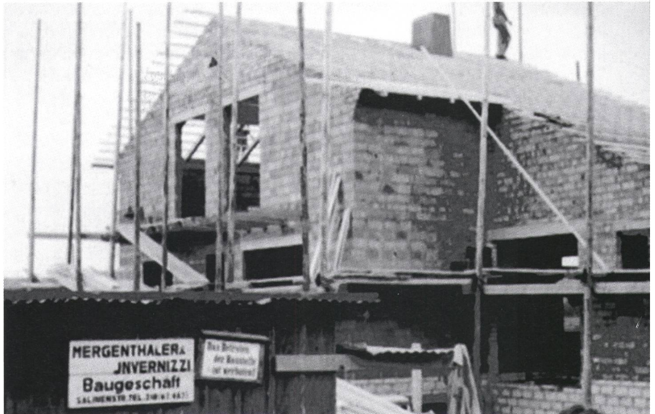
Neubau eines Einfamilienhauses
