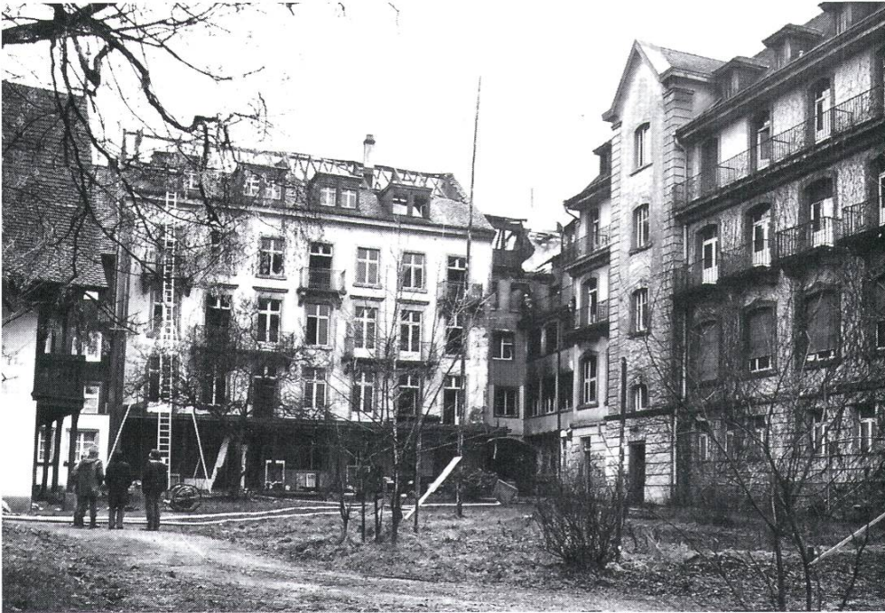
Abb. 11: Hotel Krone. Die Gartenseite kurz nach dem Brand 1980. Rechts der 1912 von Curjel & Moser errichtete Hoteltrakt, der wie sein Vorgänger quer an das Stammhaus angeschoben war.
