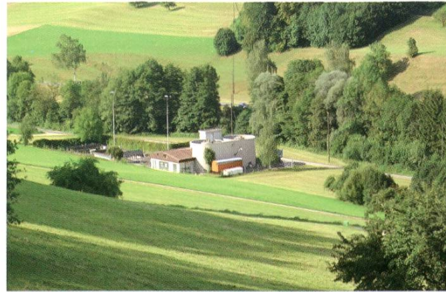
Stillgelegte Kläranlage Hellikon-Wegenstetten am 18.07.2007.
