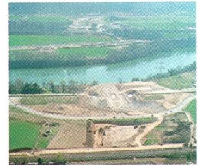
Die Baustelle im März 2002.
