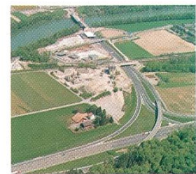
Die Baustelle im Mai 2005.
