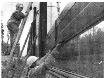
**01.09.03** Entlang des Spitals Rheinfelden entsteht in den kommenden Monaten eine für die Schweiz ungewöhnliche Lärmschutzbaute, die bis auf eine Höhe von zehn Metern reicht. Die Fachleute sprechen von einer «Halbüberdeckung» der Geleise. Die Lärmschutzbaute wird die Fahrleitungsmasten um zweieinhalb Meter überragen. Die Kosten belaufen sich auf rund drei Millionen Franken.
